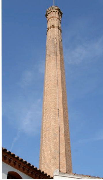
Fumeral per a l'urbanització de Els Pitufos, Paiporta
